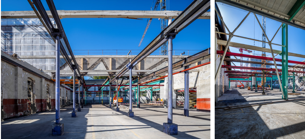
Aktueller Stand Mahlwerk Uzwil / Baustelle Shedhalle
